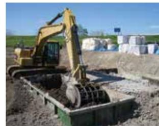
繊維質固化処理土工法による津波堆積物の再資源化
